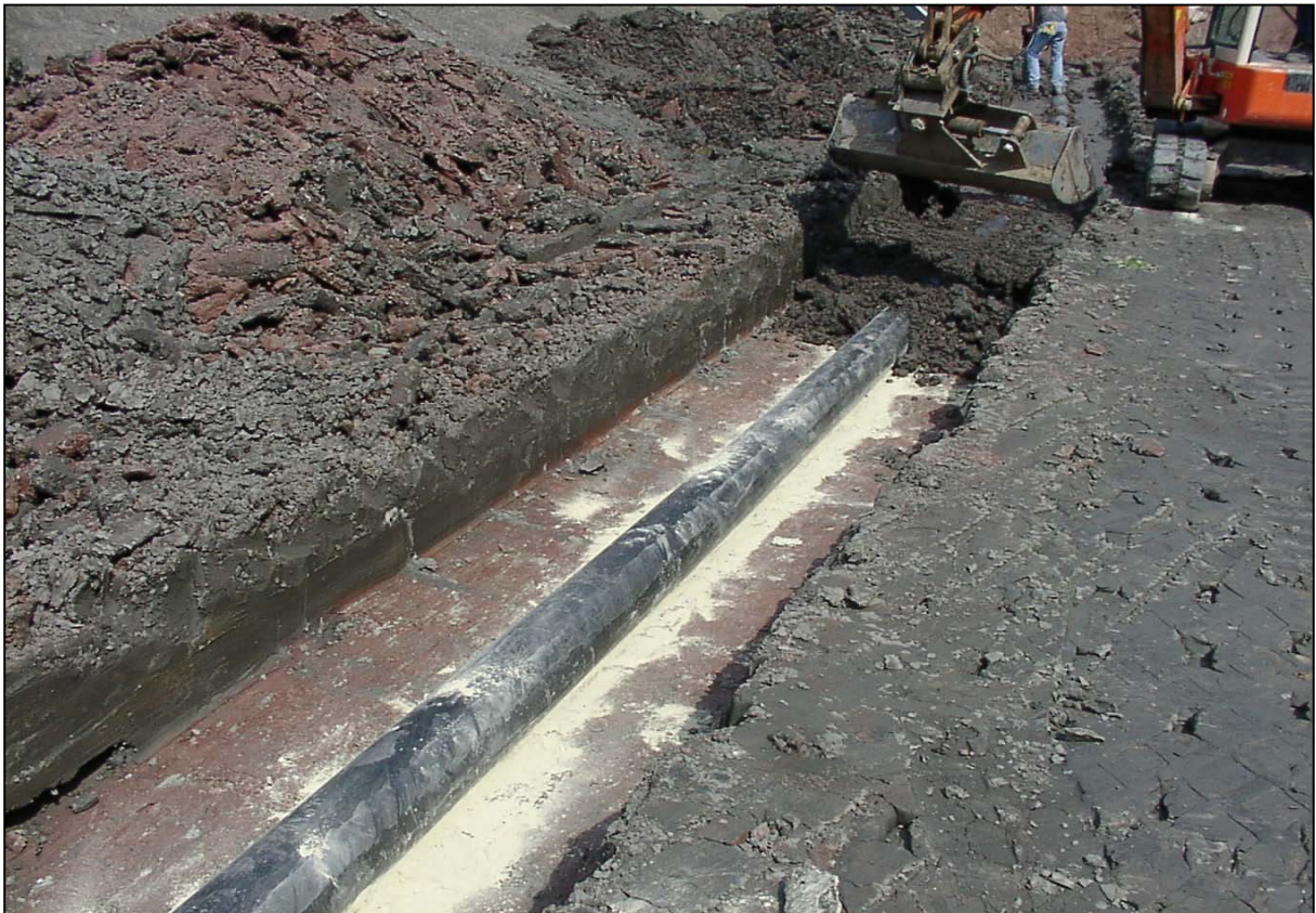
Bild 3 Auflagerherstellung
