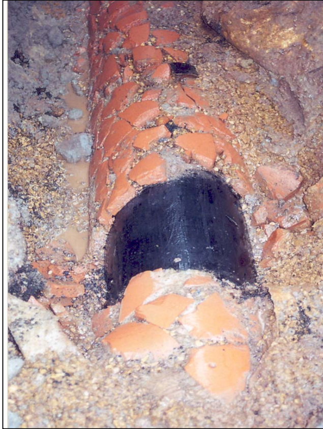
Bild 4 geberstetes Steinzeugrohr
